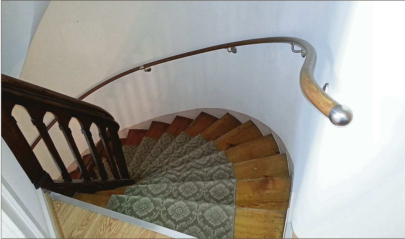
Runde Treppe mit Auslauf.
